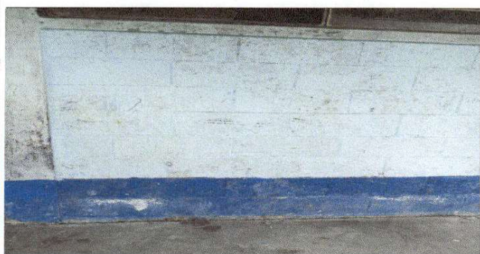
Foto 5: Pintura en muros exteriores e interiores.
