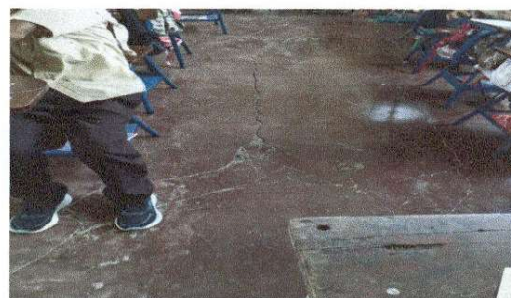
Foto 4: Sustitución de piso de torta de concreto
