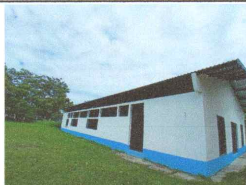
Foto 2: SUSTITUCIÓN DE ESTRUCTURA DE METAL POR PETA Y INSTALACIÓN DE LAMINA
