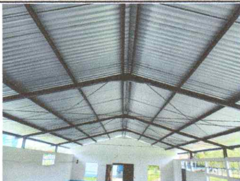
Foto1: SUSTITUCION DE LAMINA POR LAMINA TROQUELADA DEL SALÓN DEL ESTABLECIMIENTO
