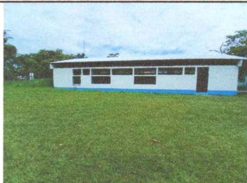
Foto 3: FABRICACIÓN DE VENTANAS E INSTALACIÓN Y FABRICACIÓN DE BALCONES
