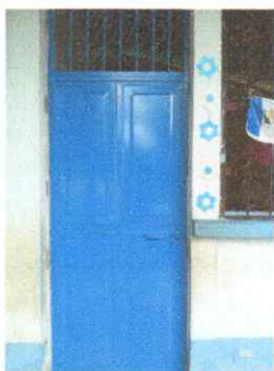
Foto 5: SUSTITUCIÓN DE 4 PUERTAS DE MADERA POR METAL
