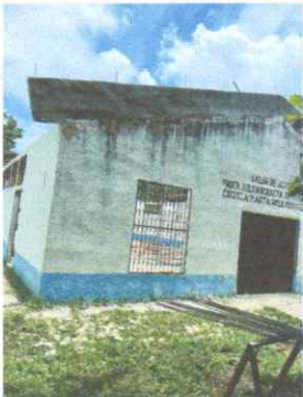
Foto 3: LEVANTA MIENTO DE MURO PERIMETRAL (MOGINETE)
