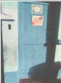
Foto 5: SUSTITUCIÓN DE 4 PUERTAS DE MADERA POR METAL
