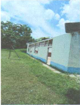
Foto 1: DESINSTALACIÓN DE LAMINA POR LAMINA TROQUELADA DEL SALÓN DEL ESTABLECIMIENTO
