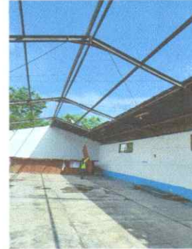
Foto 2: SUSTITUCIÓN SE ESTRUCTURA METALICA EN TECHO
