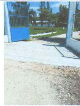
Foto 6: FABRICACIÓN E INSTALACIÓN DE PORTON DE INGRESO
