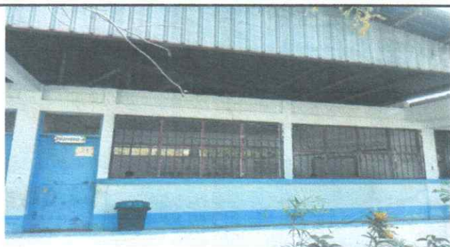
Foto 5: SUSTITUCIÓN DE 4 PUERTAS DE MADERA POR METAL
