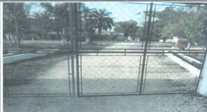
Foto 2: SUSTITUCION, FABRICACION E INSTALACION DE PORTON DE METAL DE INGRESO
