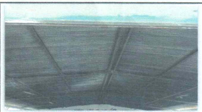
Foto 4: REPARACION DE SISTENA ELECTRICO EN AULAS Y SALON
