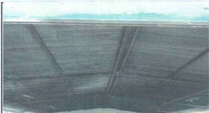
Foto 3: SUSTITUCION DE ESTRUCTURA DE SOPORTE DE METAL, POR METAL UNA PARTE UNA PARTE Y OTRA SOLO MANTENIMIENTO
