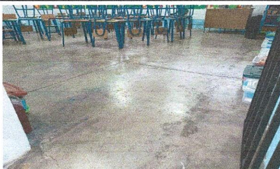
Foto 3: Mejoramiento de piso de cemento liquido a piso ceramico
