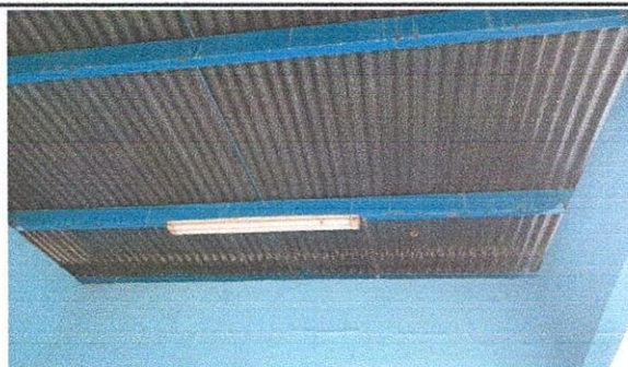
Foto 5: Sustitucion de focos y plafoneras
