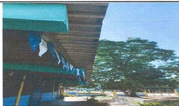
Foto 4: Mejoramiento de canal pluvial
