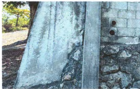
Foto: 10 Aplicación de repello de muro de contención
