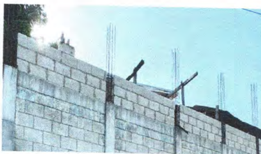
Foto: 6 Intermedias y columnas.
