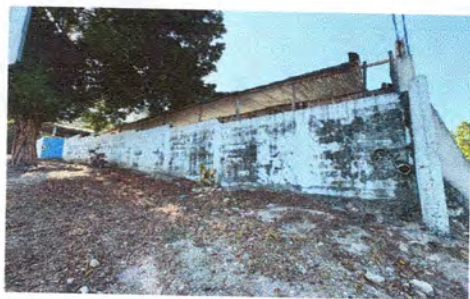
Foto 5: Reparación de muro perimetral de block.
