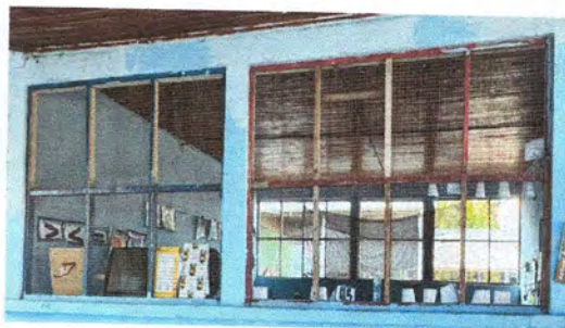
Foto: 4 Fabricación e instalación de balcones de hierro en ventana
