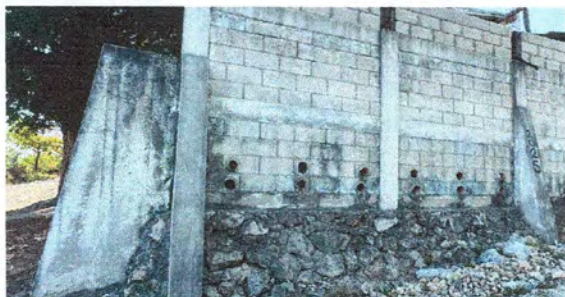
Foto: 7 Reparación de muro de contención .
