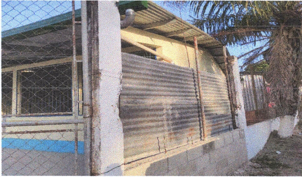
Foto 1: REPARACION DE MURO PERIMETRAL DE BLOCK, Los trabajos consisten en continuar con el levantado de muro perimetral adicionando 3 hiladas de block más la reparación de unos tramos que se encuentran en mal estado. Además de aplicar el acabo cernido más repello en el muro pegado al ingreso de la escuela, adicional se incluyen los trabajos de armado, centrado y fundición de columnas y soleras tipo U en el
