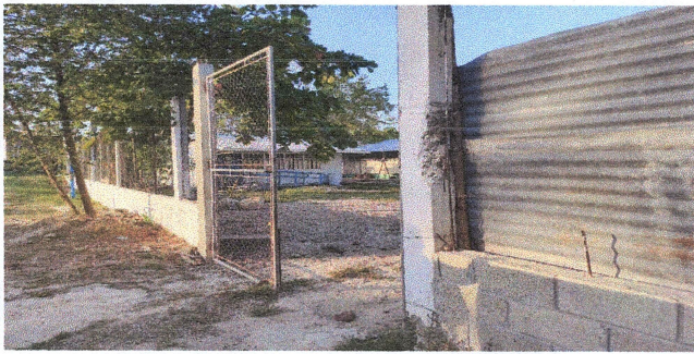
Foto 6: SUSTITUCIÓN DE PORTON DE METAL, Los trabajos consisten en la desinstalación y sustitución del porton de ingreso y la instalación de un porton totalmente nuevo con un acapado en pintura a base de aceite
