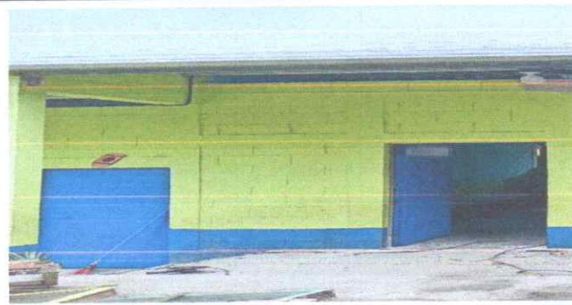
FOTO 3. SUSTITUCIÓN DE PUERTAS
