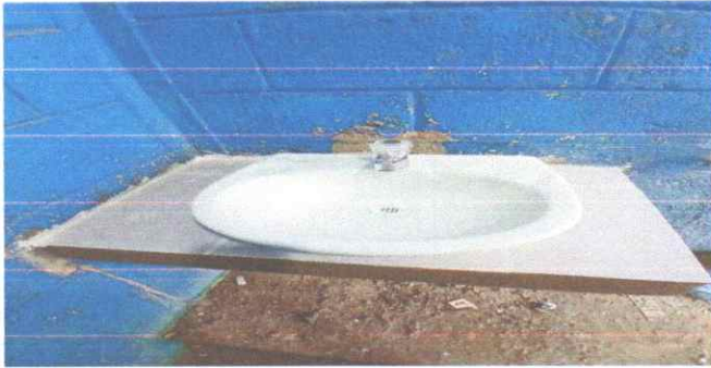
FOTO 7. SUSTITUCION DE LAVAMANOS
