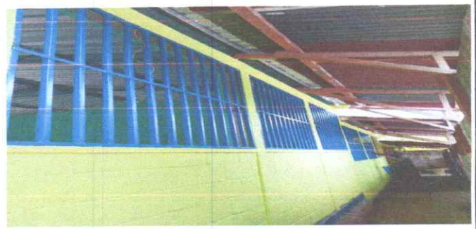
FOTO 4. SUSTITUCION DE BALCON DE METAL
