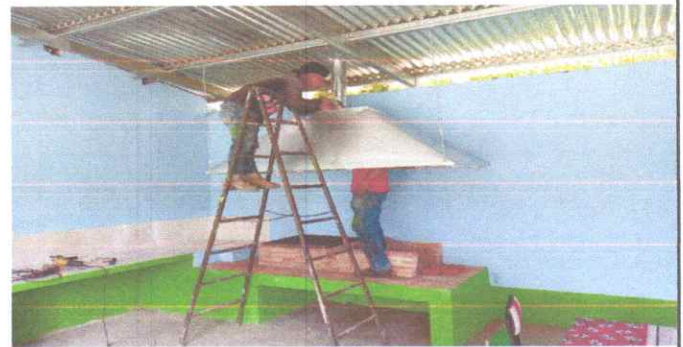
FOTO 8. SUSTITUCION DE ESTUFA RURAL COMPLETA INCLUYE CHIMENEA Y PLANCHA
