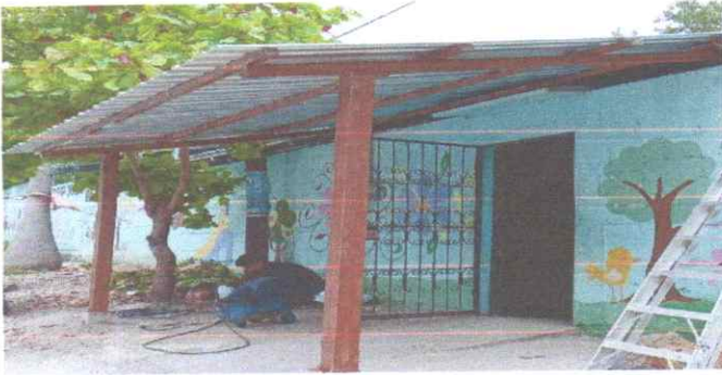
FOTO 1. SUSTITUCIÓN DE LAMINA, POR LAMINA TROQUELADA ALUZINC CALIBRE 26
