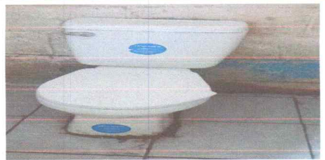
FOTO 6 SUSTITUCION DE INIDORO
