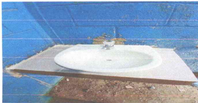
FOTO 7. SUSTITUCION DE LAVAMANOS
