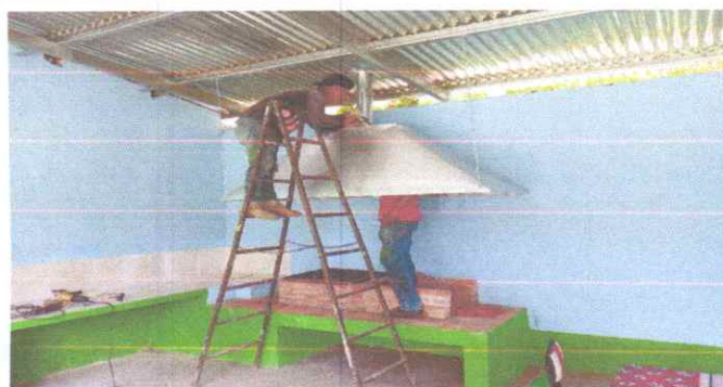
FOTO 8. SUSTITUCION DE ESTUFA RURAL COMPLETA INCLUYE CHIMENEA Y PLANCHA
