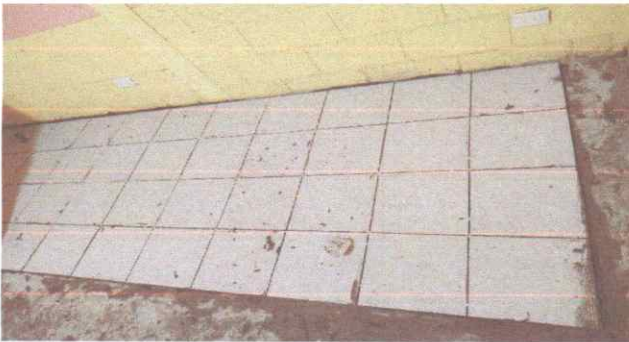
FOTO 5 SUSTITUCION DE PISO CERAMICO.
