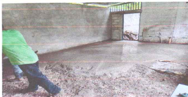
FOTO 9. SUSTITUCION DE TORTA DE CONCRETO
