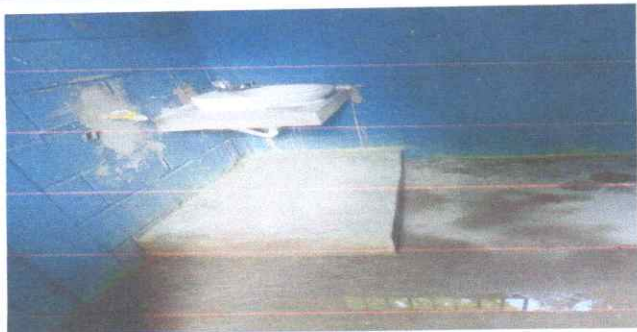
FOTO 7. SUSTITUCION DE LAVAMANOS
