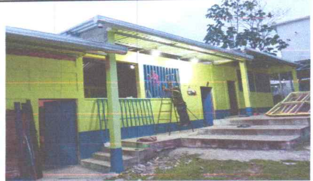
FOTO 4. SUSTITUCION DE BALCON DE METAL
