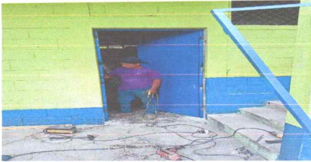
FOTO 3. SUSTITUCIÓN DE PUERTAS
