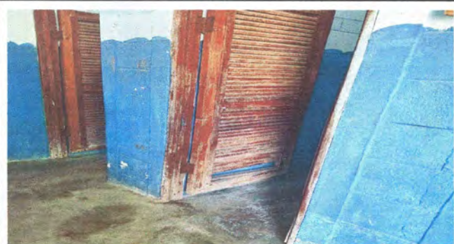
FOTO 3. SUSTITUCIÓN DE PUERTAS
