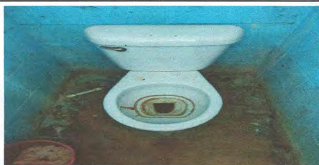
FOTO 6 SUSTITUCION DE INIDORO
