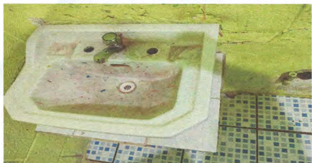
FOTO 7. SUSTITUCIÓN DE LAVAMANOS
