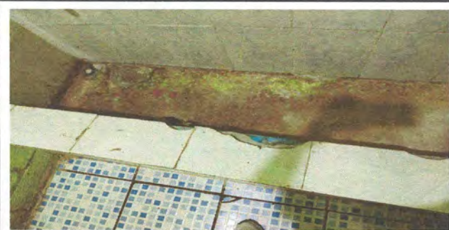
FOTO 5 SUSTITUCION DE PISO CERAMICO.
