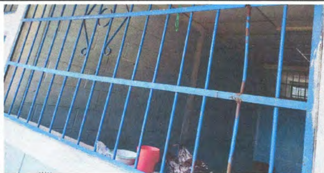
FOTO 4. SUSTITUCION DE BALCON DE METAL
