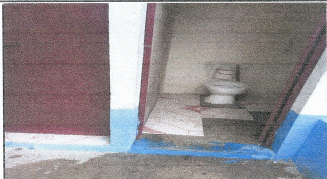
FOTO 7: REPARACIÓN DE PISO CERAMICO. Los trabajos consisten en la desinstalacion del piso exixtente, nivelación o readecuación del piso para la instación de nuevo piso ceramico en el servicio sanitario
