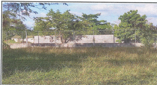
Foto 4: PINTURA EN MURO INTERIOR Y EXTERIOR. Los trabajos consisten en la palicación de pintura a base de agua en ambas caras del muro perimetral en la escuela.
