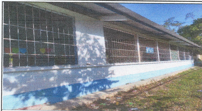
Foto 1: MANTENIMIENTO BALCONES DE METAL. Los trabajos consisten en la remoción de la pintura existentes en la estructura de balcones lijando la estructura, para luego aplicar dos manos de pintura a base de aceite en los mismos.
