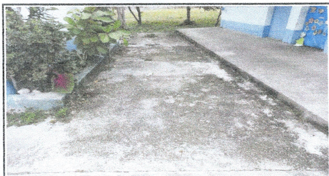
FOTO 9: SUSTITUCIÓN D EPISO TORTA DE CONCRETO, los trabajos consisten en la demolición del piso exterior existente par aluego realizar la compactación con material selecto colocación de electromalla para luego realizar la fundción del piso con acabado rustico.
