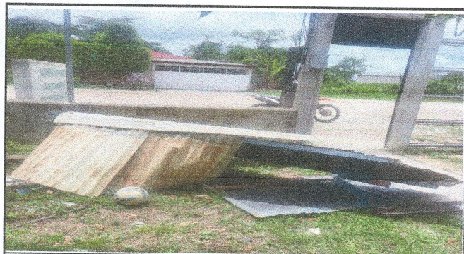
Foto 3: SUSTITUCIÓN DE ESTRUCTURA DE SOPORTE DE MADERA POR METAL. Los trabajos consisten en la sustitución de la cubierta existente sobre el porton de ingreso de la escuela por una cubierta con estructura metálica y lámina ondulada de zing cal. 28.
