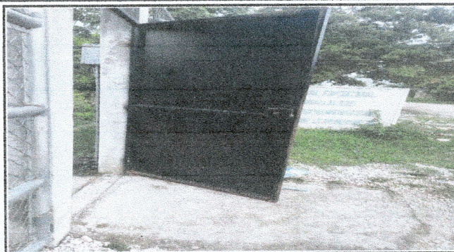
FOTO 8: MANTENIMIENTO DE ESTRUCTURA. Los trabajos consisten en la limpieza de la puerta con el lijado de toda la estructura para la remoción de la pintura existente para posteriormente aplicar dos manos de pintura a base de aceite
