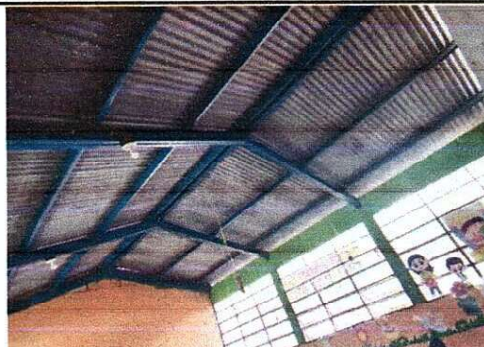
Foto 2: MANTENIMIENTO DE ESTRUCTURA DE TECHO Y SUSTITUCIÓN DE LÁMINA POR LAMINA TROQUELADA ALUZINC
