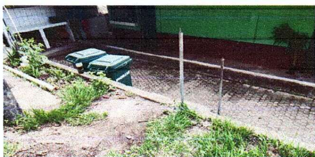
Foto 3: MEJORAMIENTO Y SUSTITUCIÓN DE BARANDAS DE METAL
