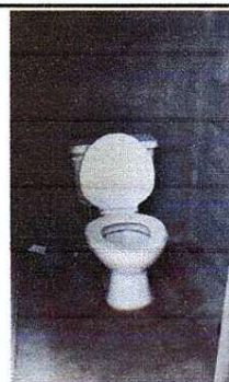
Foto 6: SUSTITUCIÓN DE DOS INODOROS
