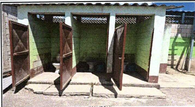
Foto 2 Mejoramiento de baños
