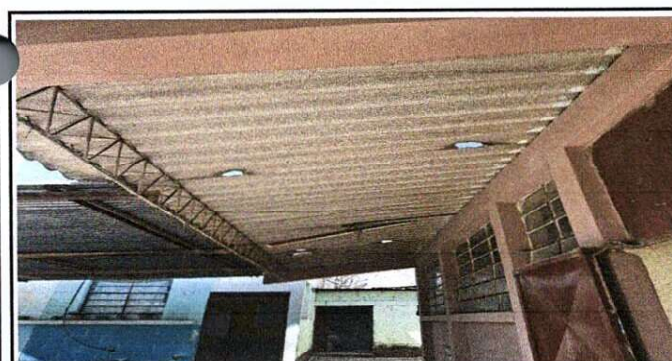
Foto 5: Mejoramiento de techado
