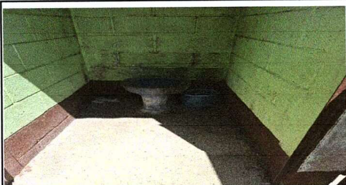
Foto 1 Mejoramiento de baños
