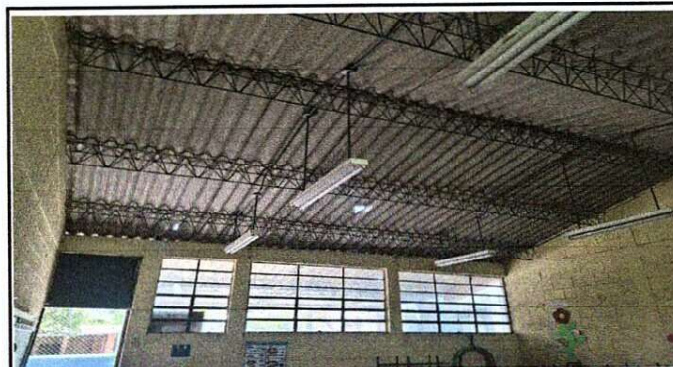
Foto 4 Mejoramiento de techado
