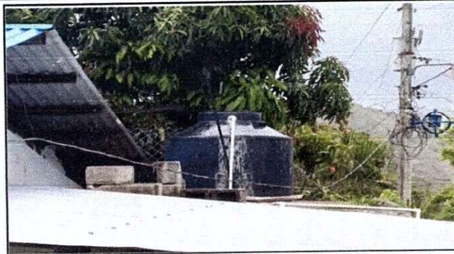
Foto 2: SUSTITUCIÓN DE TINACO
