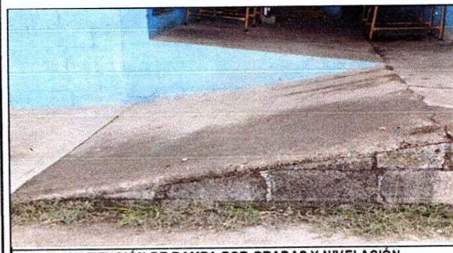
Foto 5: SUSTITUCIÓN DE RAMPA POR GRADAS Y NIVELACIÓN
