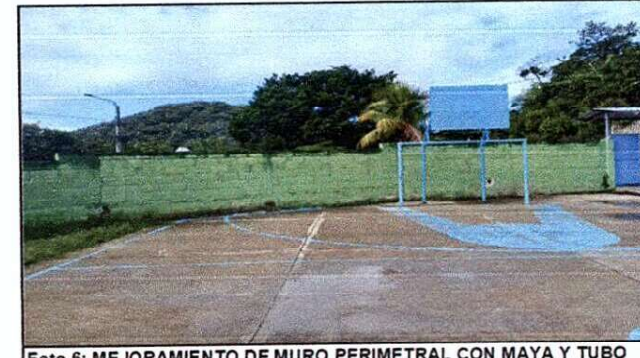
Foto 6: MEJORAMIENTO DE MURO PERIMETRAL CON MAYA Y TUBO GALVANIZADO
