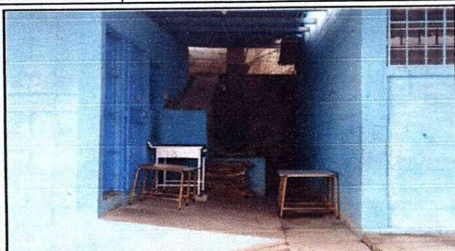
Foto1: MEJORAMIENTO DE LA COSINA
