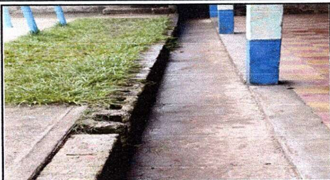
Foto 7: SUSTITUCION DE MURO DE CONTENCIÓN
