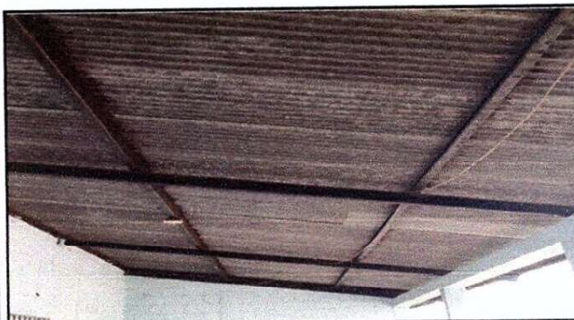
Foto 3: SUSTITUCIÓN DE LAMINA POR LAMINA TROQUELADA ALUZIN CALIBRE 26
