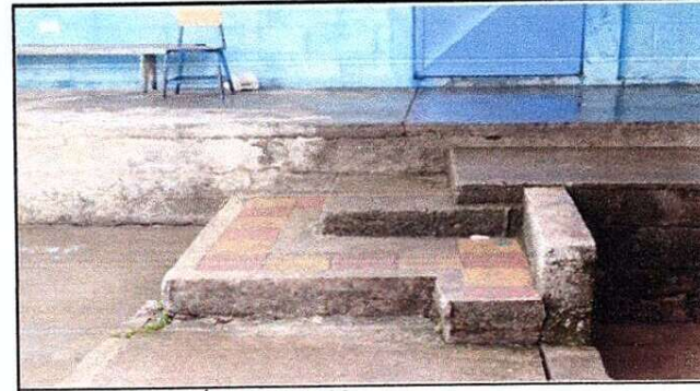
Foto 4: SUSTITUCIÓN DE GRADAS
