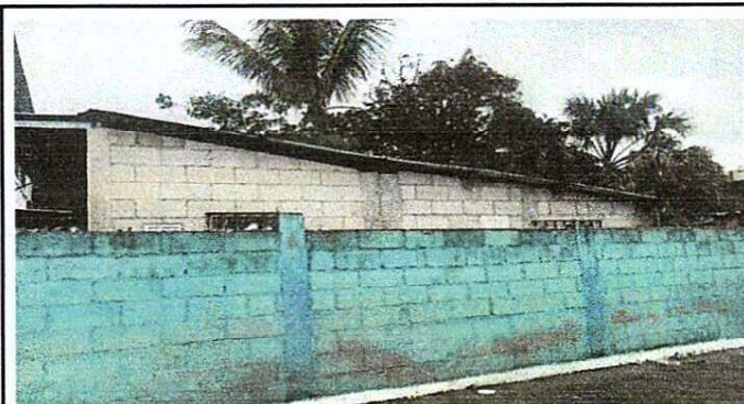
Foto 1 Mejora muro perimetral
