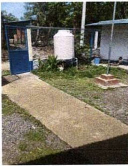
Foto 1: Mejoramiento de base para tinaco
