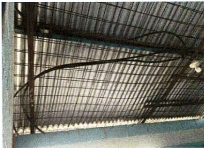
Foto 3: Mejoramiento sistema eléctrico.
