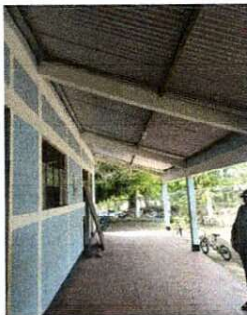
Foto 3: Mantenimiento a Estructura portante de techo, Sustitución de ventanas
