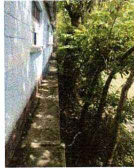
Foto 2: Mantenimiento de pintura de muros exteriores e interiores
