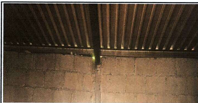
Foto 5: Sustitución Cubierta de Lamina
