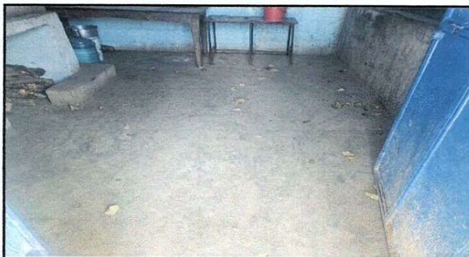
Foto 3: Sustitución de piso tipo ceramico
