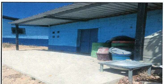
Foto 6: Sustitución de cubierta de lamina con estructura
