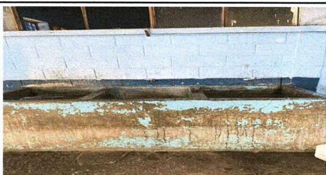
Foto 5: MEJORAMIENTO DE PILA
