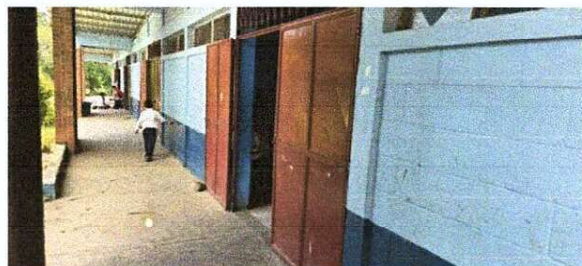
Foto 4: APLICACIÓN DE PINTURA EN MUROS EXTERIORES
