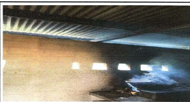
Foto 6: MEJORAMIENTO DE TECHADO COCINA
