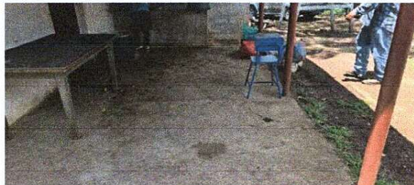
Foto 2: INSTALACIÓN DE PISO TIPO DUELA
