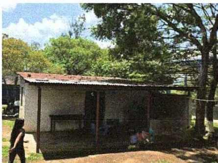
Foto 3: AMPLIACIÓN DE COCINA Y CAMBIO ALTURA DE MURO
