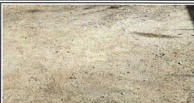
Foto 2: Mejoramiento de piso
