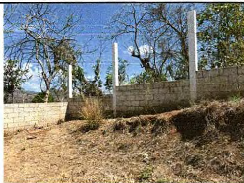
FOTO 2: MEJORAMIENTO DE COLUMNAS C-1
