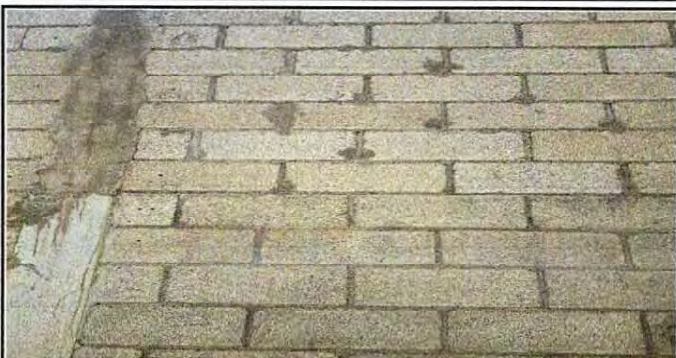
Foto1: Mejoramiento de muro
