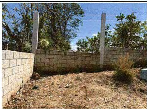
FOTO 1: MEJORAMIENTO MURO DE BLOCK DE MAMPOSTERIA
