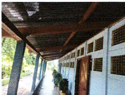
Foto 2: SUSTITUCIÓN DE CUBIERTA DE LAMINA
