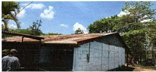
Foto1: SUSTITUCIÓN DE CUBIERTA DE LAMINA
