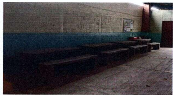
Foto 4: PATIO MEJORAMIENTO DE MESAS Y BANCAS
