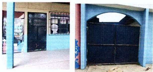
Foto 6: MANTENIMIENTO DE PUERTAS Y PORTON
