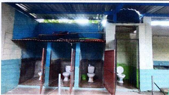
Foto 3: MEJORAMIENTO DE BAÑOS Y SUSTITUCIÓN DE PUERTAS
