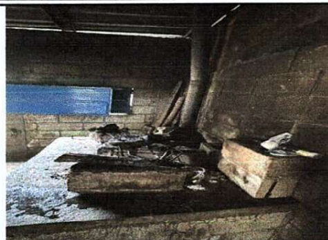
Foto 2: REPARACIÓN O SUSTITUCIÓN DE ÁREA DE COCINA
