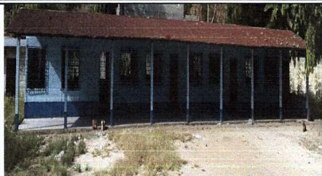
Foto 1: CUBIERTA DE LÁMINA
