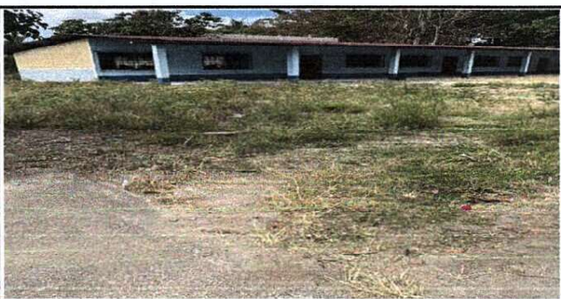
Foto 5: LOSA DE PATIO
