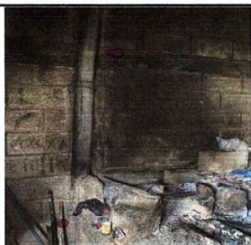
Foto 3: REPARACIÓN DE REPELO Y CERNIDO DE PAREDES
