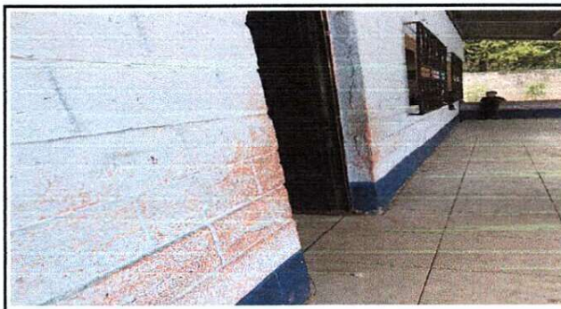
Foto 4: PINTURA DE MUROS INTERIORES Y EXTERIORES
