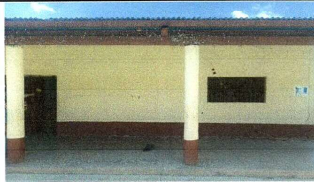
Foto 2: ESTRUCTURA DE TECHO
