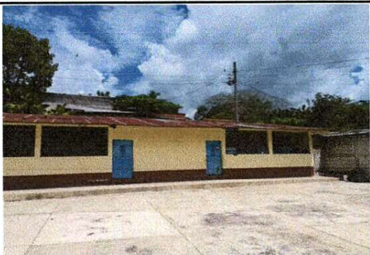
Foto1: CUBIERTA DE LAMINA
