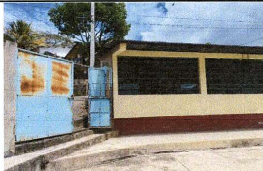
Foto 6: PUERTAS DE METAL
