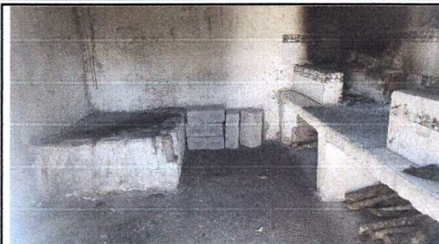
Foto 2: REPARACIÓN O SUSTITUCIÓN DE ÁREA DE COCINA
