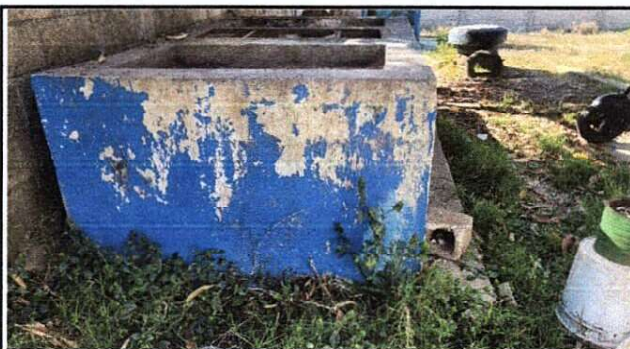
Foto 3: REPARACIÓN Y MANTENIMIENTO DE CISTERNAS/DEPÓSITOS DE AGUA
