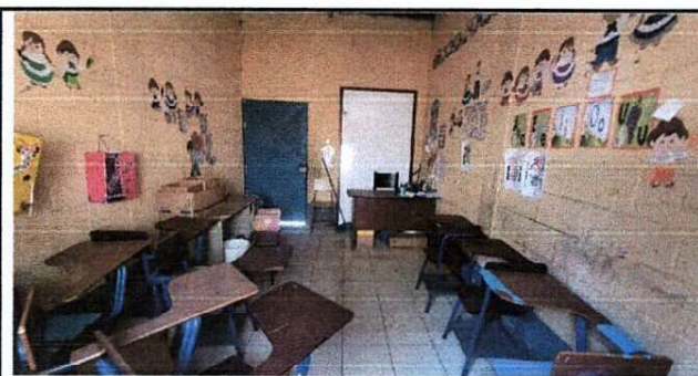
Foto 5: REPARACIÓN DE MUROS
