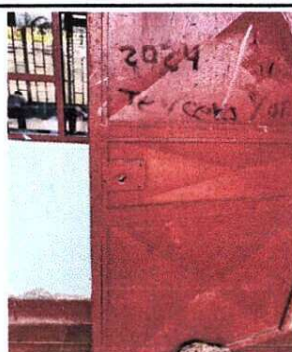
Foto 6: PUERTAS Y PORTON DE METAL
