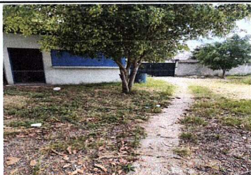
Foto 3: LOSA DE PATIO
