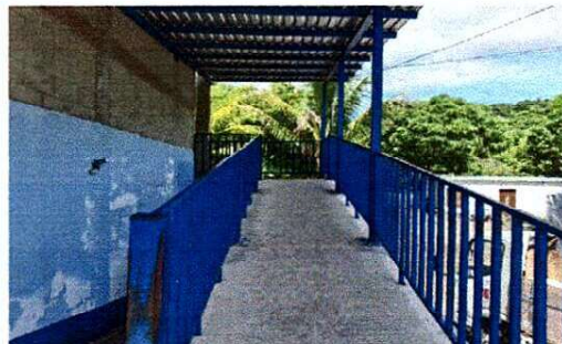
Foto 4: MEJORAMIENTO DE BARANDAS
