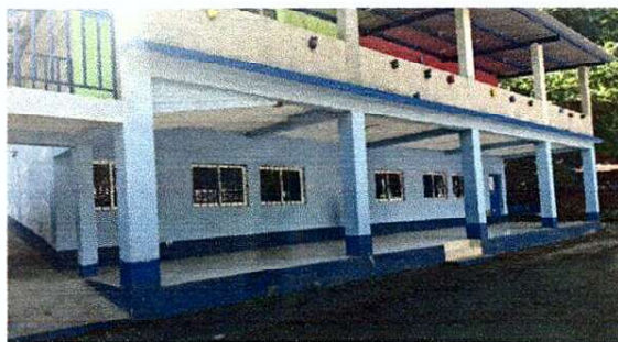
Foto 2: FABRICACIÓN DE BARANDAS DE METAL
