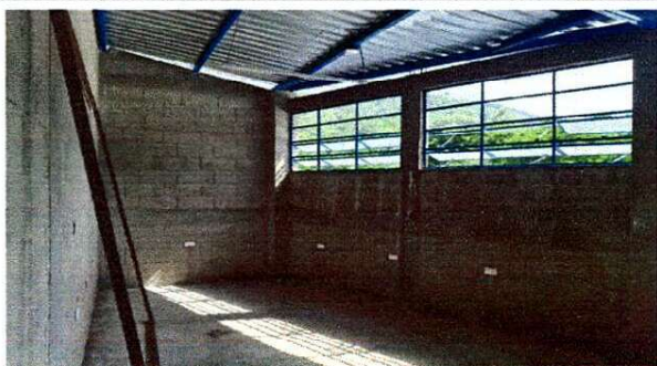
Foto1: ELABORACIÓN DE LOSA DE CONCRETO E INSTALACIÓN DE PISO CERAMICO
