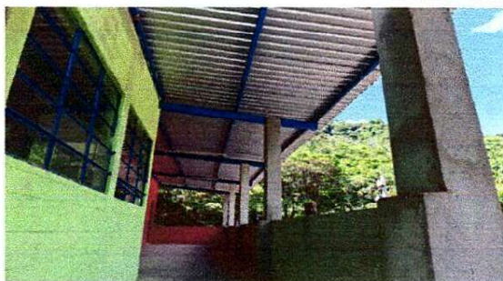
Foto 5: INSTALACIÓN DE BARANDA DE METAL
