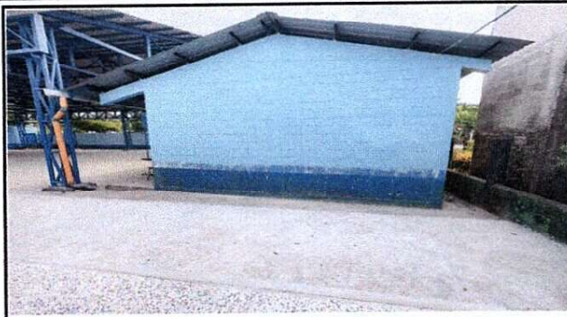
Foto 2: ESTRUCTURA DE TECHO
