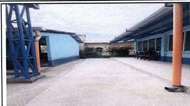
Foto1: CUBIERTA DE LAMINA
