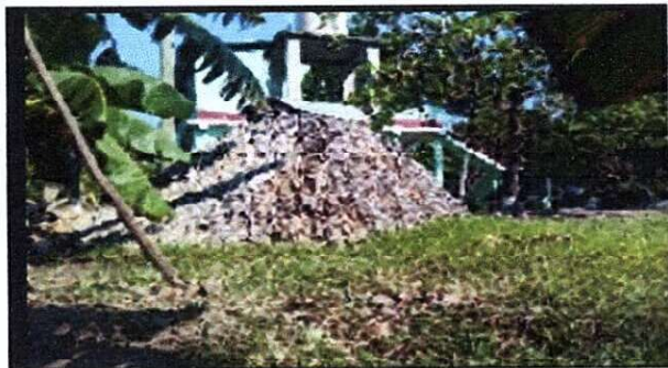
Foto 3: SUSTITUCIÓN DE PAREDES VENTANAS, PUERTA Y PISO
