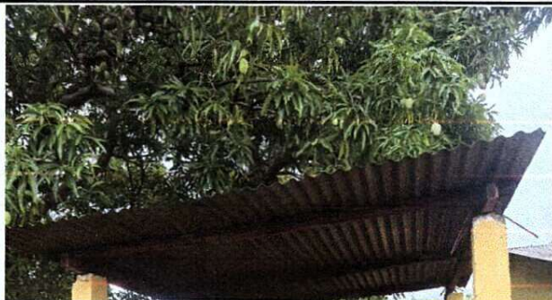
Foto 3: SUSTITUCIÓN DE LAMINA POR LAMINA TROQUELADA ALUCINC CALIBRE 26
