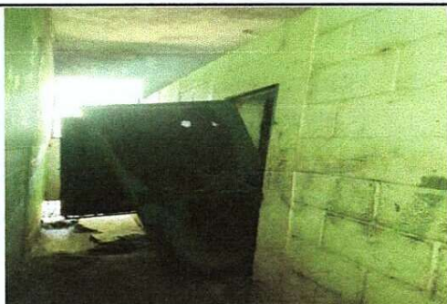
SUSTITUCIÓN DE PUERTA
