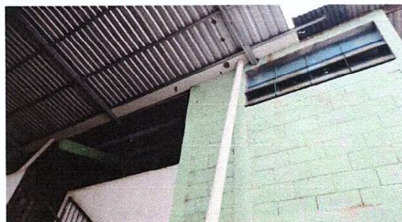
REPARACIÓN DE BAJADA DE AGUA PLUVIAL DE 6 PULGADS
