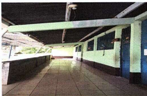
SUSTITUCIÓN DE LAMINA POR LAMINA TROQUELADA ALUCINC CALIBRE 26
