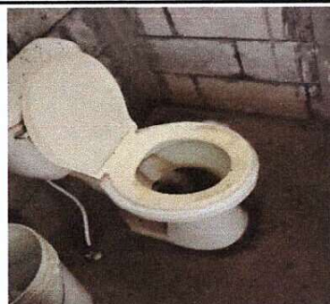
SUSTITUCIÓN DE INODORO
