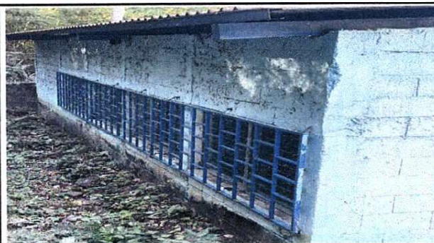
Foto 4: CUNETA DE CONCRETO
