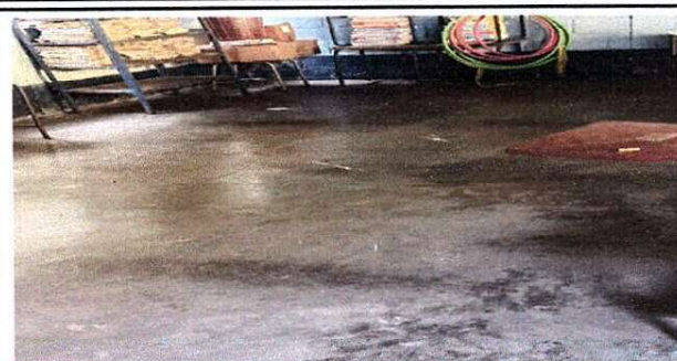
Foto 2: SUSTITUCIÓN DE PISO CERAMICO
