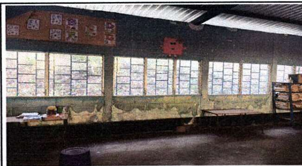
Foto 6: PINTURA EN MUROS EXTERIORES E INTERIORES
