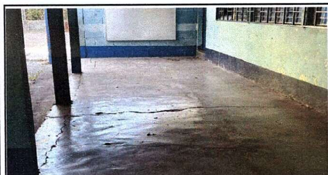
Foto 3: SUSTITUCIÓN Y REPARACIÓN DE CONTRA PISO DE CONCRETO
