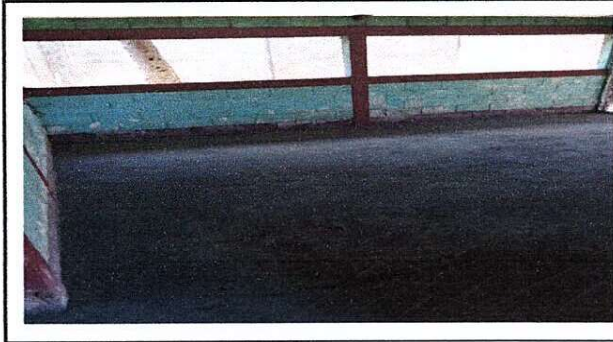
Foto 6: SUSTITUCION DE BALCONES DE METAL
