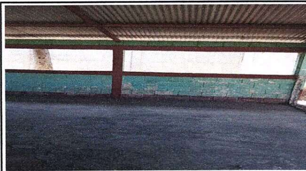
Foto 4: SUSTITUCIÓN DE PISO CERAMICO
