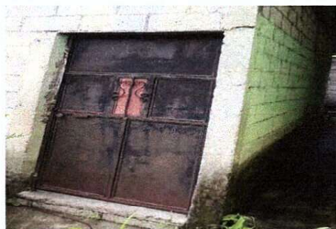
Foto 5: SUSTITUCIÓN DE PUERTA
