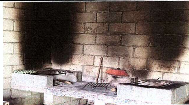
Foto 2: SUSTITUCIÓN DE ESTUFA RURAL (COMPLETA) INCLUYE CHIMENEA Y PLANCHA DE METAL
