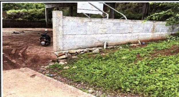
Foto 3: REPARACIÓN DE MURO DE CONTENCIÓN
