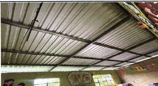
Foto 6: REPARACIÓN DE SISTEMA ELÉCTRICO
