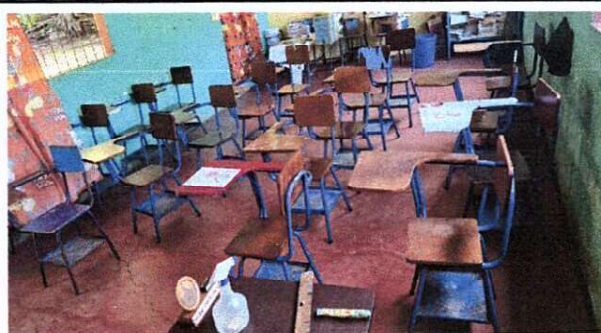
Foto 4: SUSTITUCIÓN DE PISO CERAMICO
