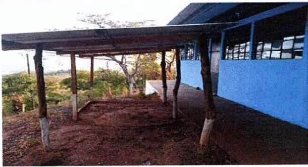
Foto 1: REPARACIÓN DE COCINA
