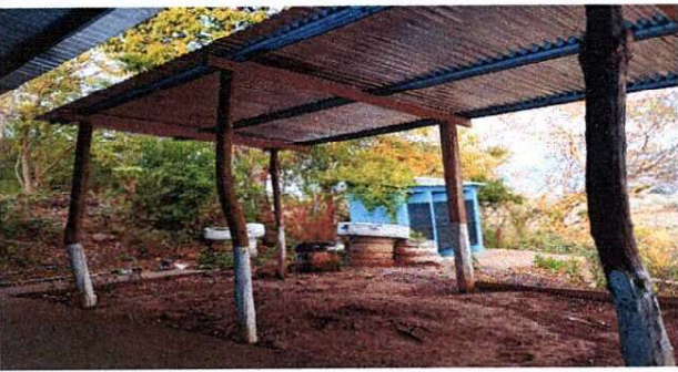
Foto 3: CUBIERTA DE LAMINA
