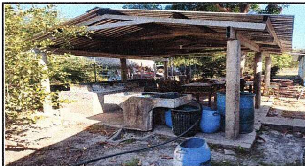
Foto 6: MEJORAMIENTO DE PARED DE COCINA
