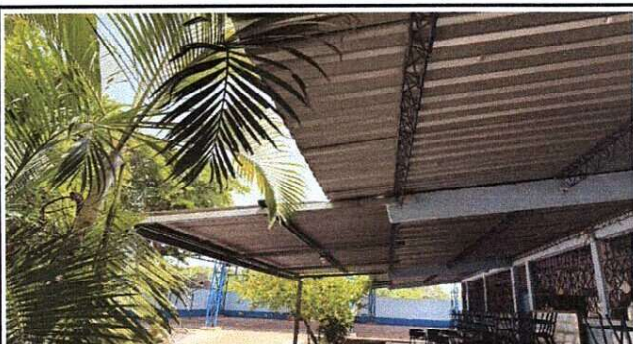
Foto 3: CUBIERTA DE LAMINA
