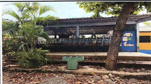
Foto 2: MEJORAMIENTO DE PARED DE AULA
