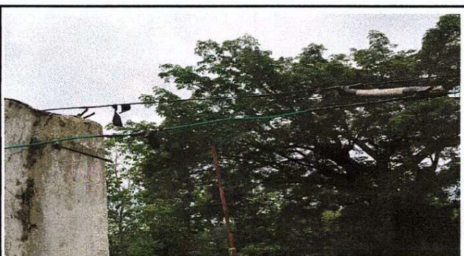
Foto 4: Reparación de sistema eléctrico
