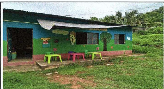
Foto 3: Ampliacion de piso de concreto
