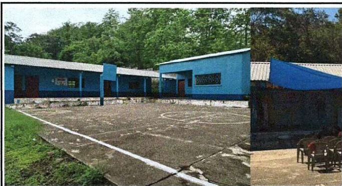
Foto1: Ampliación y mejoramiento de cubierta de lamina y sustitucion de canales de bajada de agua pluvial
