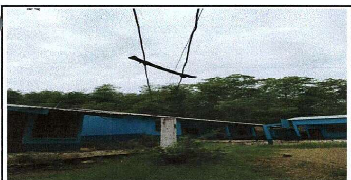
Foto 5: Reparación de sistema eléctrico
