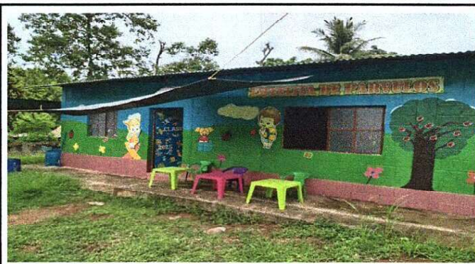
Foto 2: Ampliación y mejoramiento de cubierta de lamina y estructura
