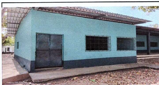
Foto 3: Sustitución y mantenimiento de puertas ventanas y balcones
