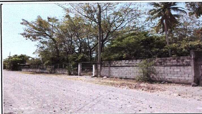
Foto 2: Repello y pintura en muro perimetral. Mantenimiento de portón de entrada
