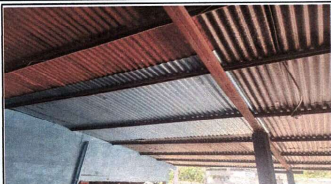
Foto 1: SUSTITUCION LAMINA POR LAMINA TROQUELADA CALIBRE 26
