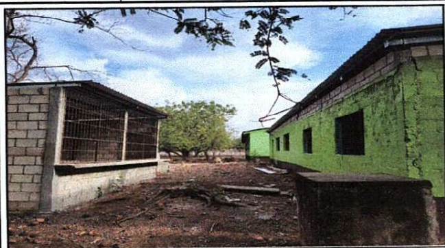
Foto 1: Ampliación de techo de cocina y entortado de cemento
