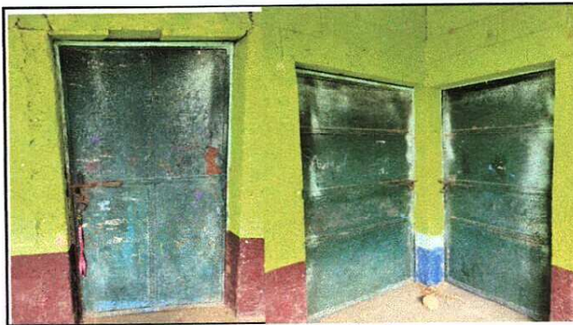
Foto 4: Mantenimiento de estructura de puertas de aulas
