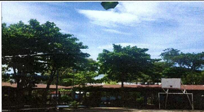
Foto1: CUBIERTA DE LÁMINA DE GALERAS
