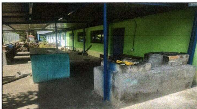
Foto 3: REPARACIÓN DE COCINA
