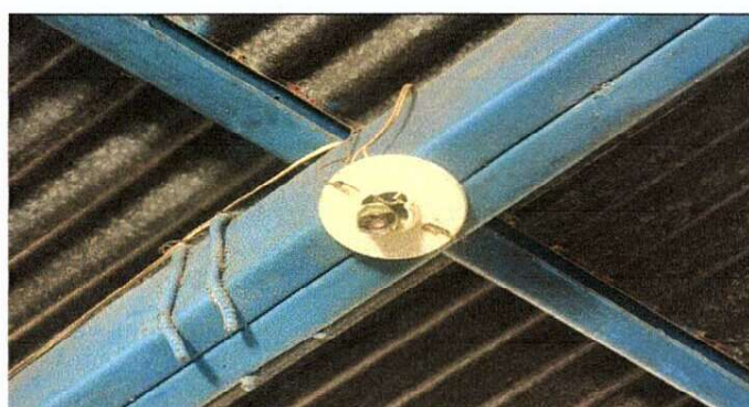
Foto 6: REPARACIÓN DEL SISTEMA ELÉCTRICO
