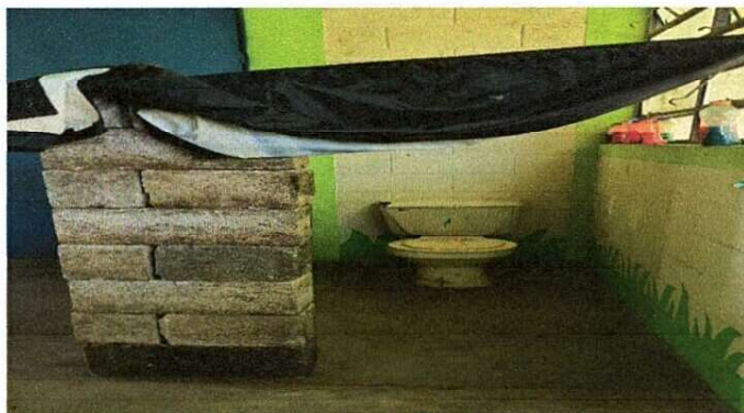
Foto 4: MEJORAMIENTO DE SERVICIOS SANITARIOS
