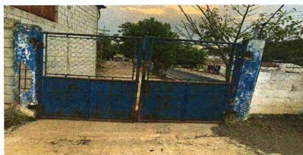
Foto 12: ACCESO PRINCIPAL: Reparación de portón en mal estado (lijado, pintura y colocación de nueva malla)
