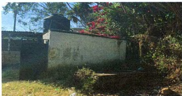
Foto 7: MÓDULO SANITARIO: Sustrucción de costaneras de madera en mal estado por de 4x2 legítima estructura portante con costanera metálica de 4x2 legítima, sustrucción de lámina en mal estado por lámina troquelada calibre 26, elaboración de levantado de mojinetes.
