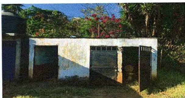
Foto 5: MODULO SANITARIO: Sustitución de cuatro sanitarios en mal estado por sanitarios de porcelana (incluye accesorios)
