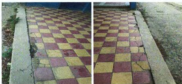
Foto 11: MÓDULO CORREDOR: Sustrucción de piso de cemento en mal estado por piso cerámico.
