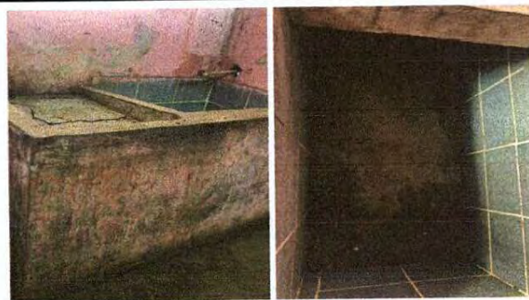
Foto 4: MODULO COCINA: Mejoramiento de pila de block con azulejo (completa).
