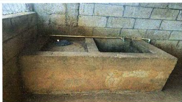
Foto 10: MÓDULO SANITARIO: Mejoramiento de la pila de block con la colocación de azulejo.
