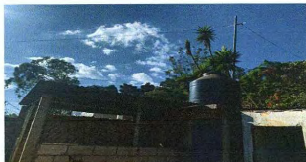
Foto 8: MÓDULO SANITARIO: MÓDULO SANITARIO: Sustrucción de tinaco en mal estado por uno nuevo de 2,500 Litros (incluye accesorios).
