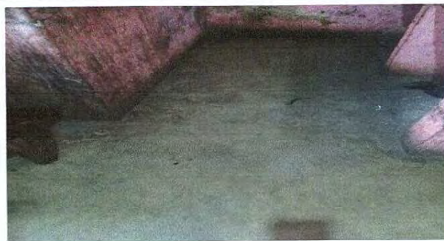
Foto 2: MODULO COCINA: Sustitución de torta de cemento en mal estado por piso cerámico.
