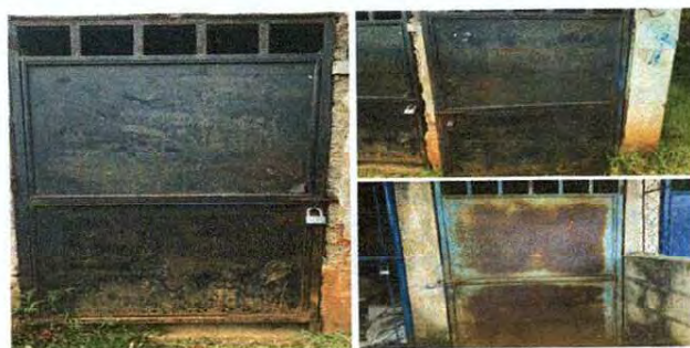
Foto 6: MÓDULO SANITARIO: Reparación de tres puertas de metal en mal estado y pintura.
