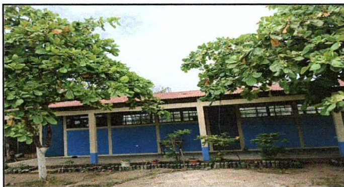
Foto 3: Sustitución de techo
