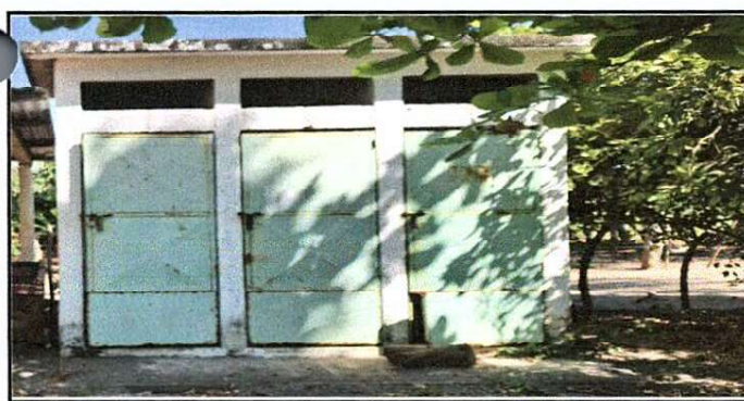
Foto 5: Sustitución de puertas de metal de sanitarios
