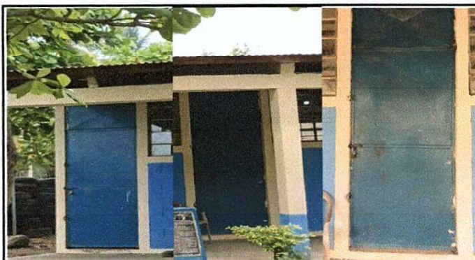
Foto 4: Sustitución de puertas de metal
