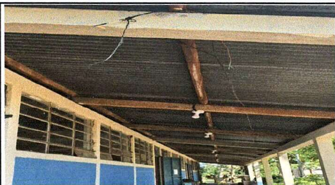
Foto1: Sustitución de estructura de metal por metal
