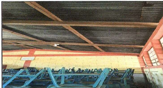
Foto 2: Sustitución de lámina por lámina troquelada
