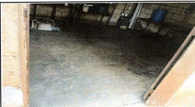
Foto 4: Reparación de piso de concreto
