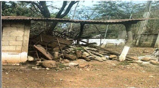
Foto 1: Ampliación de pared
