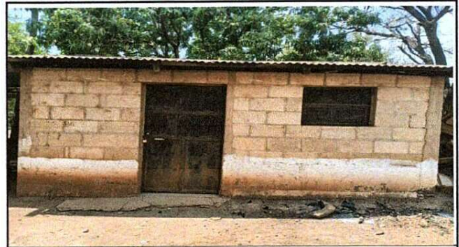
Foto 2: Reparación de puertas y ventanas de metal
