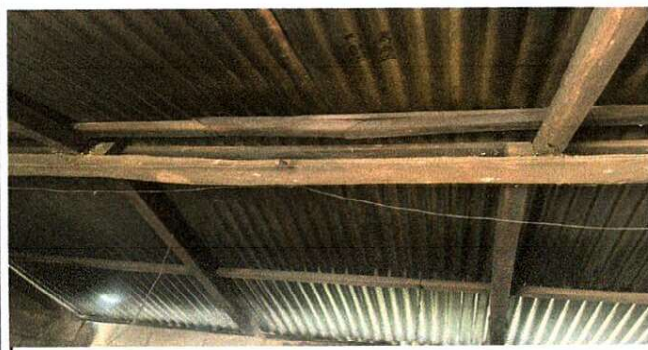
Foto 3: Sustrucción de estructura de madera por metal
