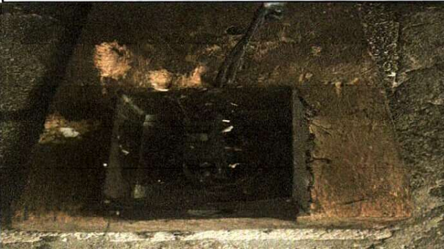
Foto 3: Sustitución de sistema eléctrico
