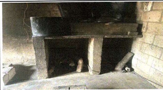
Foto 2: Sustrucción de estufa rural y chimenea
