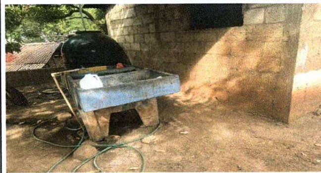
Foto 5: Sustrucción de pila de concreto
