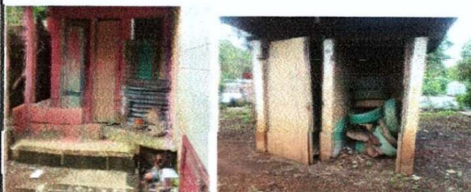
Foto 3: MODULO SANITARIO Torta de cemento rústica en fosa séptica para ampliar, sustitución 3 puertas de madera y lámina por puerta de metal.
