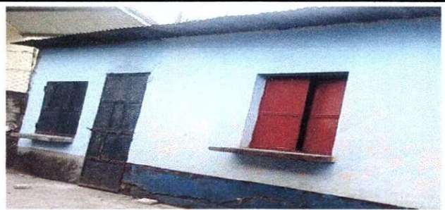
Foto 6 MODULO COCINA: Sustitucion de ventana de metal en mal estado por una de metal x 1.30.
