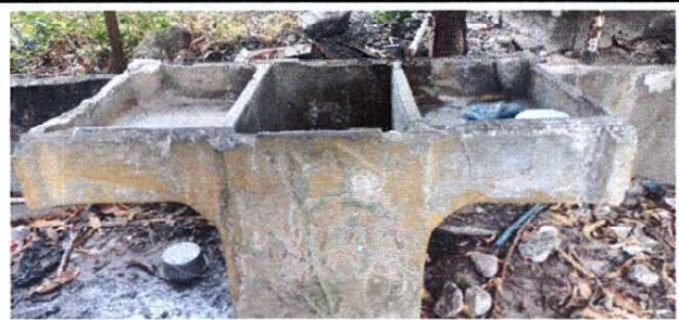
Foto 11: MODULO COCINA: Elaboracion de pila de cemento en sustitucion de pila prefabricada.
