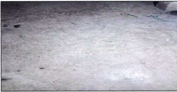
Foto 7: MODULO COCINA: Sustitucion de piso de cemento por piso ceramico.
