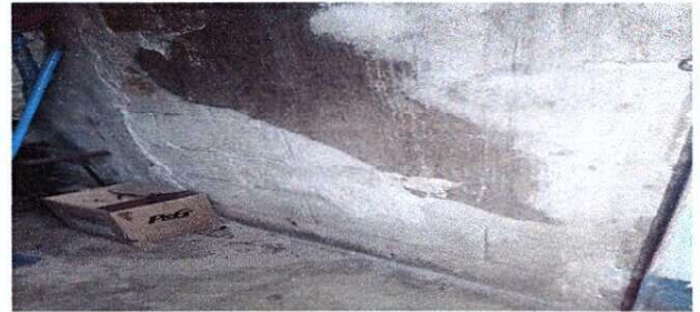
Foto 2 MODULO COCINA: Repello en paredes internas y externas
