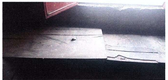
Foto 4 MODULO COCINA: Elaboracion de desayunoador de cemento
