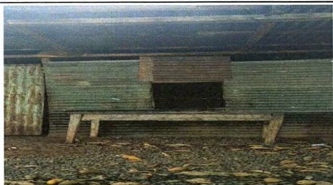
Foto 7: Area de cocina para instalación de ventanas metálicas de 1x1 metro con pasadores de seguridad.
