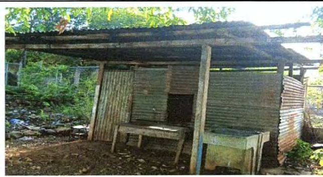
Foto 2: Estructura de soporte de madera en mal estado para sustituirla con estructura metálica galvanizada en cocina.
