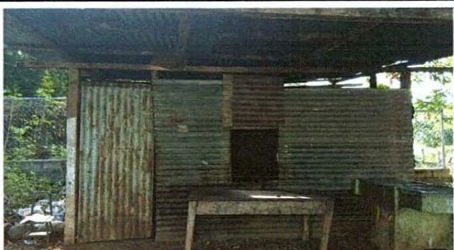
Foto 9: Area de cocina para ampliación con paredes de block y pilares de concreto.
