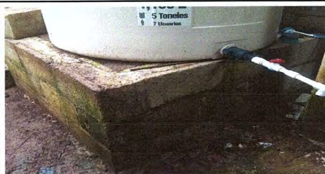
Foto 8: Base provisional para tinaco de captación de agua a sustituir por torre de estructura metálica de 2x 1.50 metros con tubo galvanizado.
