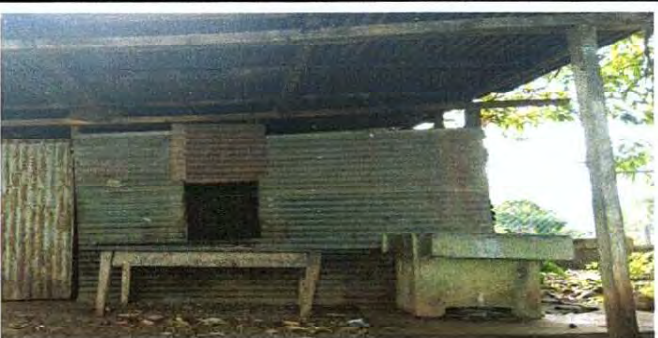
Foto 11: Pila de cemento dañada de tanque de almacenaje. Se instalará pila prefabricada de dos lavaderos en área externa de cocina
