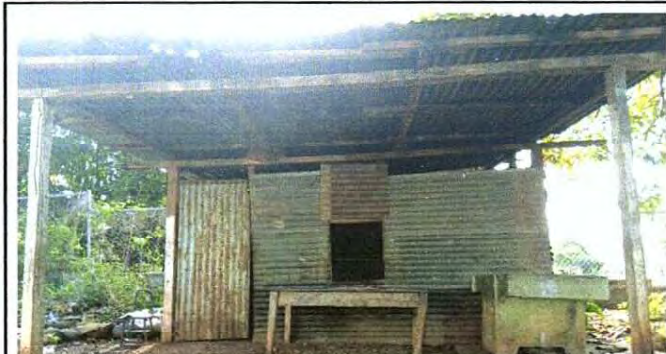
Foto 1: Lámina de cocina en mal estado a sustituir con lámina troquelada Aluzinc calibre 26
