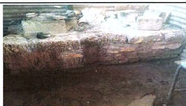
Foto 4: Piso de torta de cemento en mal estado a mejorar con piso cerámico en área interna de cocina (previa nivelación con torta de concreto)
