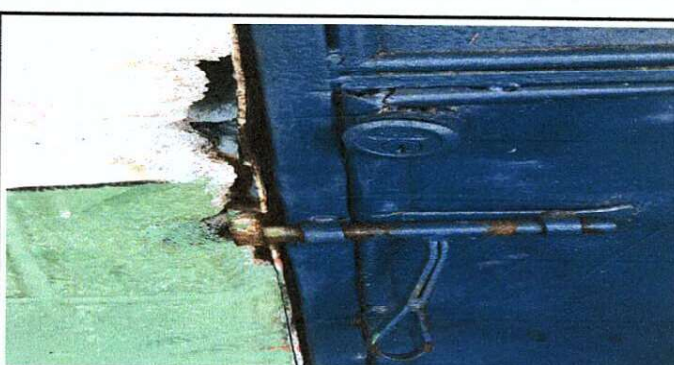
Foto 6: Sustitución de chapas en mal estrado, en puertas.
