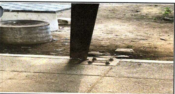
Foto 5: Reparación de Bases de soporte de estructuras
