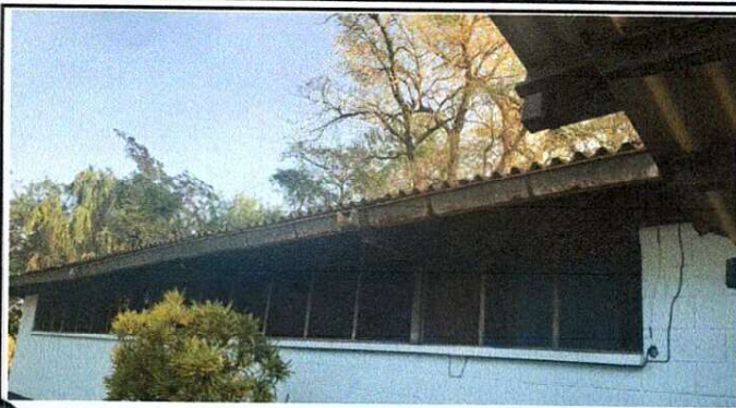
Foto 1: Cambio de techo de Advesto por lámina troquelada C26.
