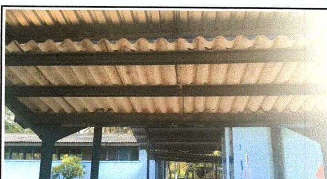
Foto 4: Cambio de techo de Advesto en (03) caídas de agua.
