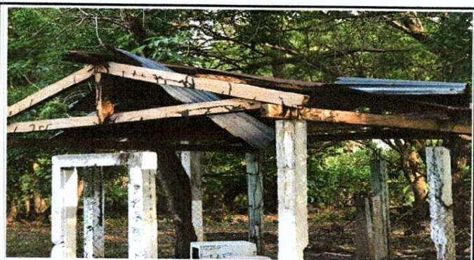
Foto 3: Cambio de techo y estructura de metal, galera de pozo.
