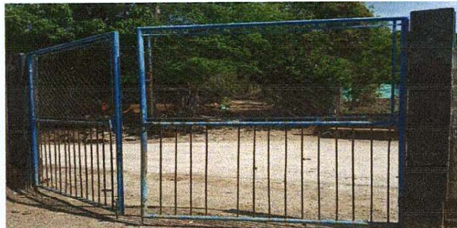
Foto 8: Reparación/Mejoramiento de portón de malla y tubos metalico por lamina lisa en acceso principal
