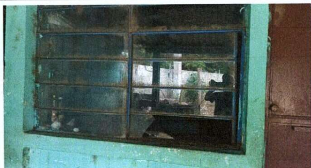
Foto 3: Reparación de ventana en mal estado en area de cocina
