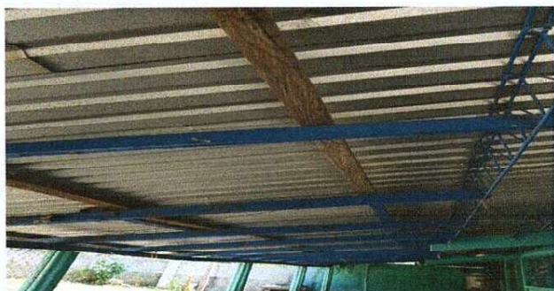
Foto 7: Sustitución de soporte de madera por estructura Metálica, Y sustitución de lamanina dañada por lamina troquelada calibre 26 en corredor
