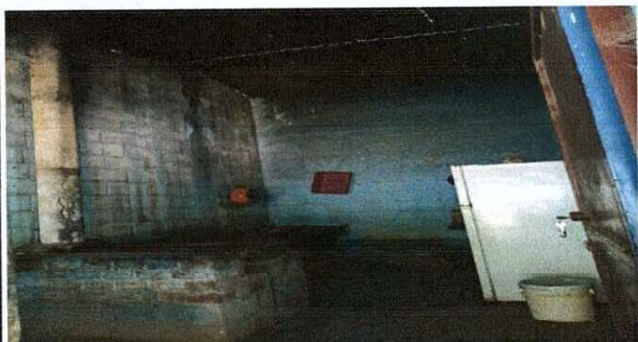
Foto1: Mejoramiento de polleton, sustitución de torta de cemento por piso de cerámico, repello de paredes internas debido a malas condiciones
