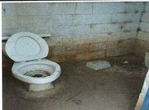
Foto 4: Sustitución de baños en mal estado, Sustitución de torta de cemento por piso cerámico.
