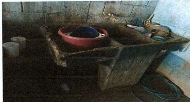
Foto 2: Remodelación de pileta con block y azulejo debido a pila prefabricada en mal estado.
