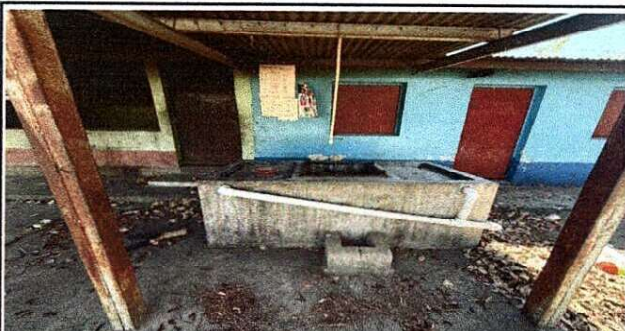
Foto 5: REPARACION DE PILA Y PINTURA
