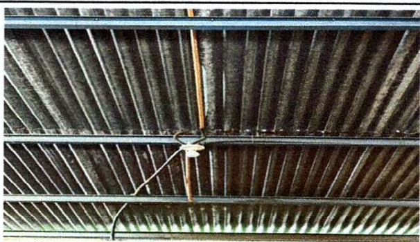
Foto1: CAMBIO DE LAMINA Y PINTURA DE COSTANERA
