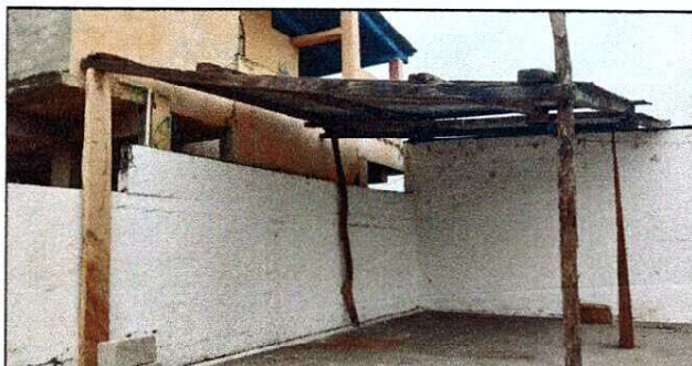
Foto 6: SUSTITUCION DE LAMINA Y ESTRUCTURA
