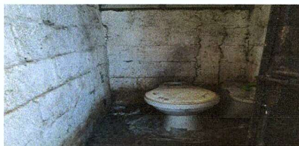
Foto 6: Sanitario destruido a sustituir, torta de cemento dañada y sin lavamanos.
