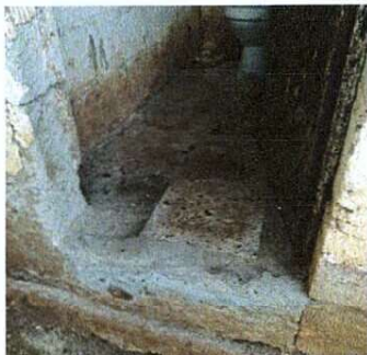
Foto 7: Area para instalación de mingitorios y para mejoramiento de torta de cemento.
